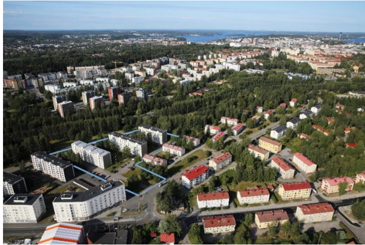
Näkymä suunnittelualueen koillispuolelta länteen, etualalla Kissanmaan- ja Hippoksenkadut, oikealla ylhäällä Tampereen keskusta. Kaavamuutosalue rajattu etualalla sinisellä.
